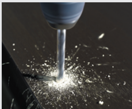
1. Сверление отверстия в легкой панели
